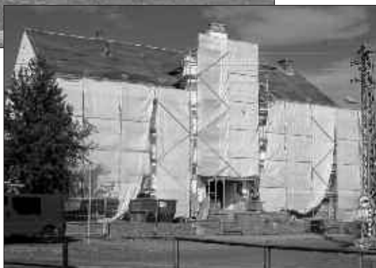
Grundschule Niederlichtenau Südfassade im Bau (KP II)
