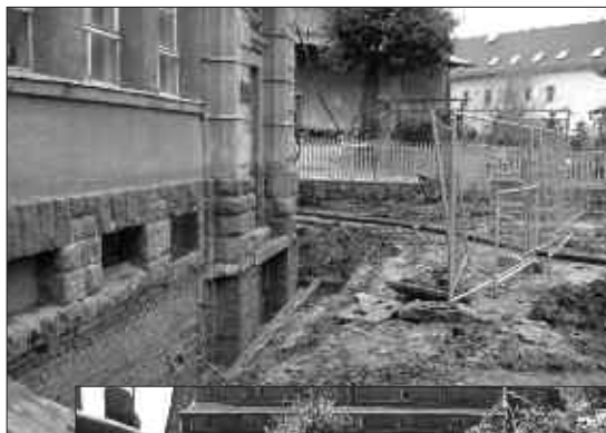
Neue Mittelschule Lichtenau im Bau Trockenlegung
