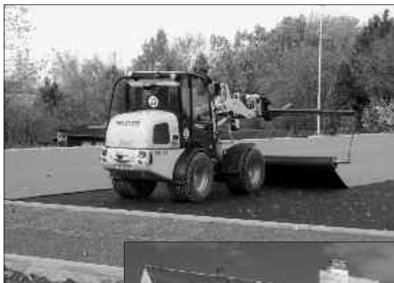
Verlegung Kunstrasen Sportplatz 1 Rathausstraße (KP II)
